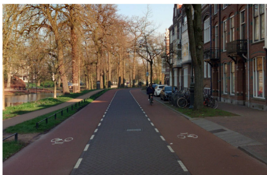
Referentieafbeeldingen van gebiedsontsluitingswegen (30 km/u) met een relatief smal wegdeel van klinkerverharding met aan beide zijden een fietsstrook van asfalt
